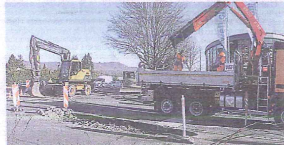
Die Bauarbeiten am Kreisel Ost haben begonnen und dauern bis im November.
