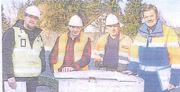
Simon Thaller, Uwe Bauer, Andreas Stäubli und Andreas Drohomirecki bei der Baustellenbesprechung.
