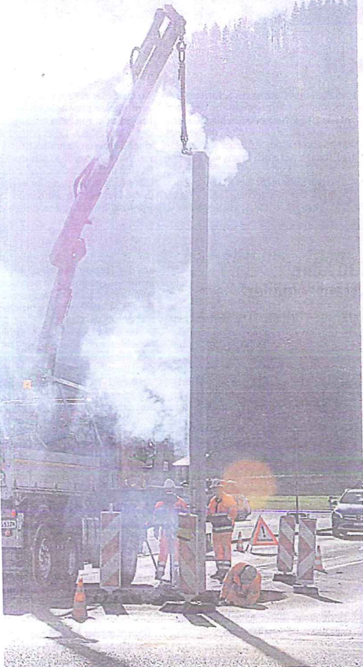
Stallpfosten der einstigen Lichtsignalanlage wird durchtrennt.
